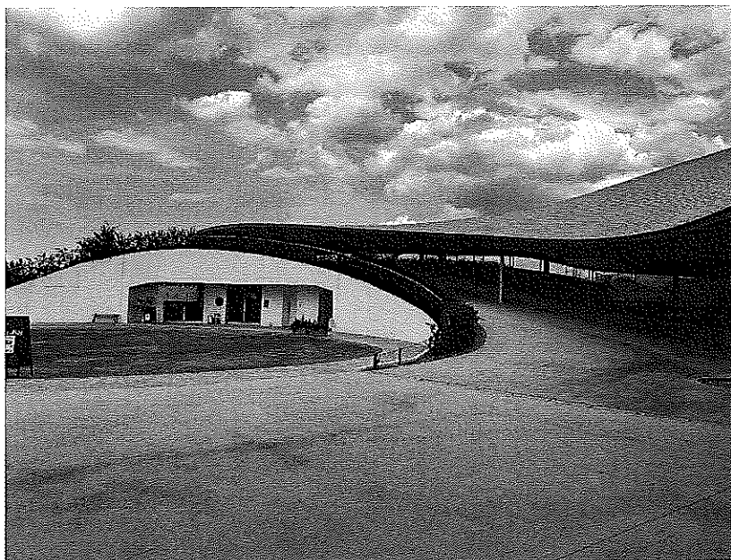
コパル外観（曲線的な屋根とカフェスペース）
