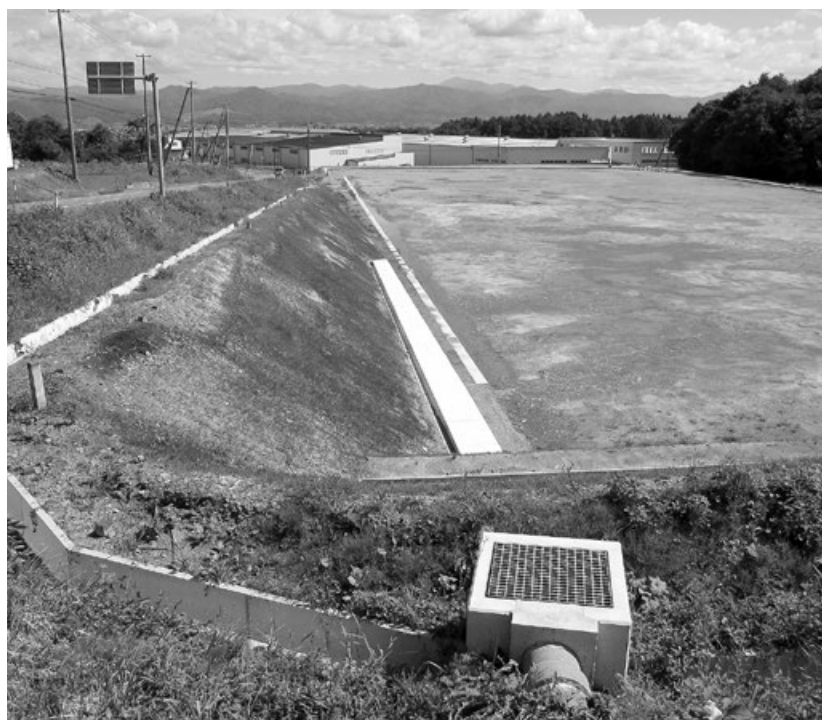
町道に隣接する造成地
