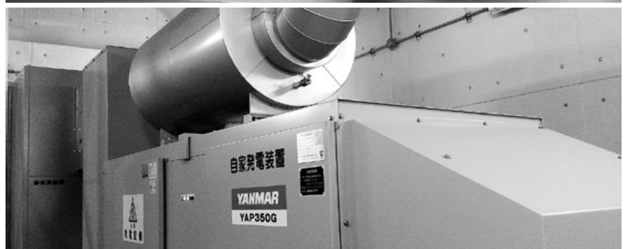
災害に備えた東部配水場（藤沢地区）
