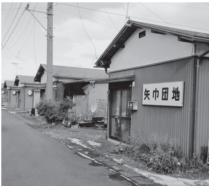
建築から57年経過している町営住宅
