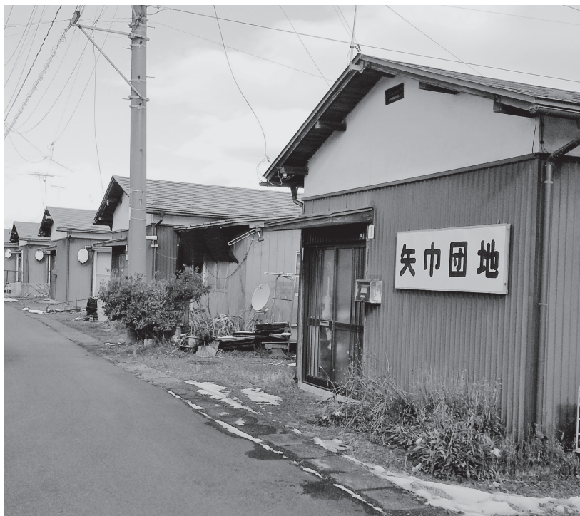
建築から57年経過している町営住宅
