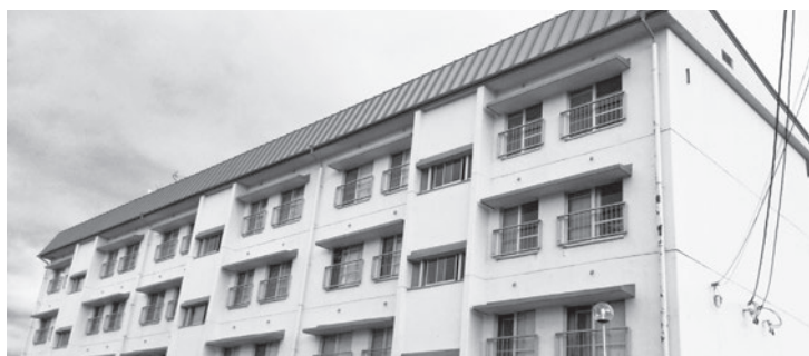
屋根の修繕を終えた三堤住宅1号棟
