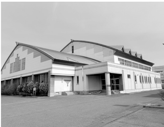
早期の空調設備設置を待ち望む (写真は矢巾北中学校)
