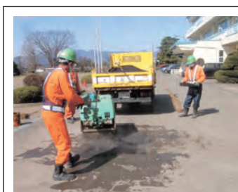
徳田小学校での作業の様子
